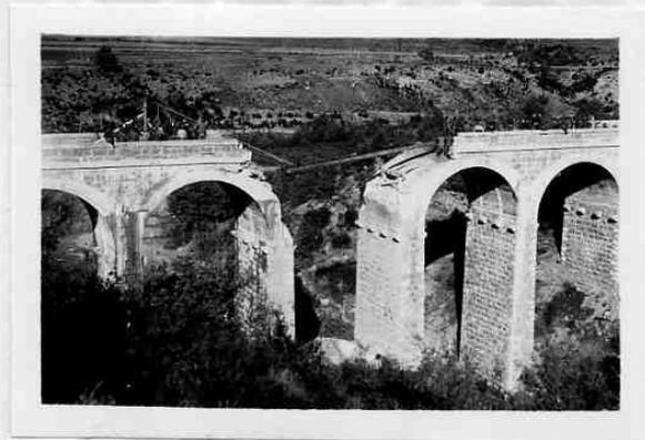
CONSTRUCCION.- Cuatro vigas de doble T.P.N. 32, aprestadas bajo las rodaduras con travesseros y tablero de madera (tipo reglamentario en la Agrupación); por el tipo de voladura fué necesario levantar el apoyo de las vigas, por medio de caballetes de madera, para conseguir que el tablero quedara enrasado con el firme de la carretera.
